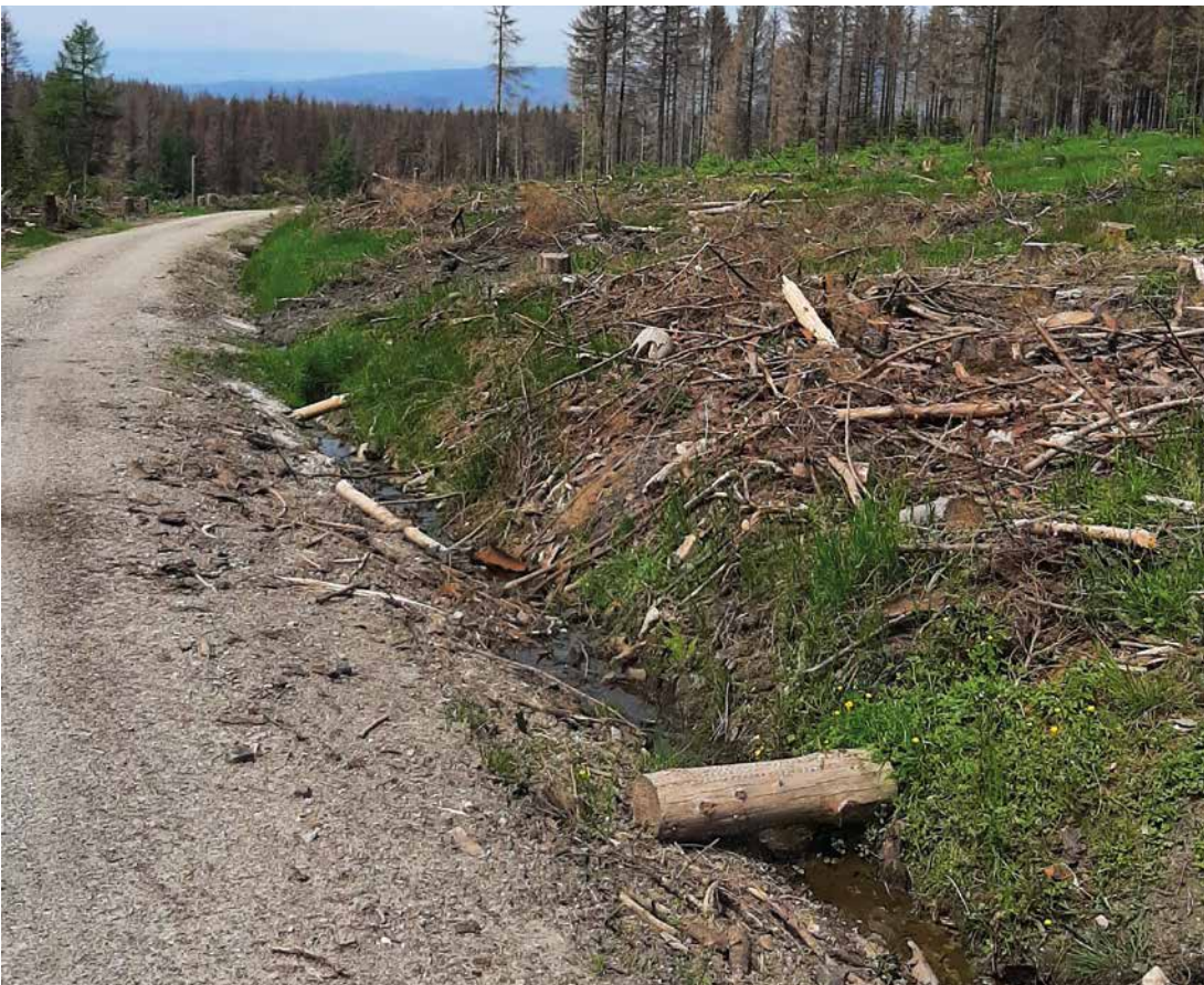
Abb. 5: Nach der Holzernte liegendegebliebene Holzreste verstopfen den Graben und behindern den Wasserabfluss
